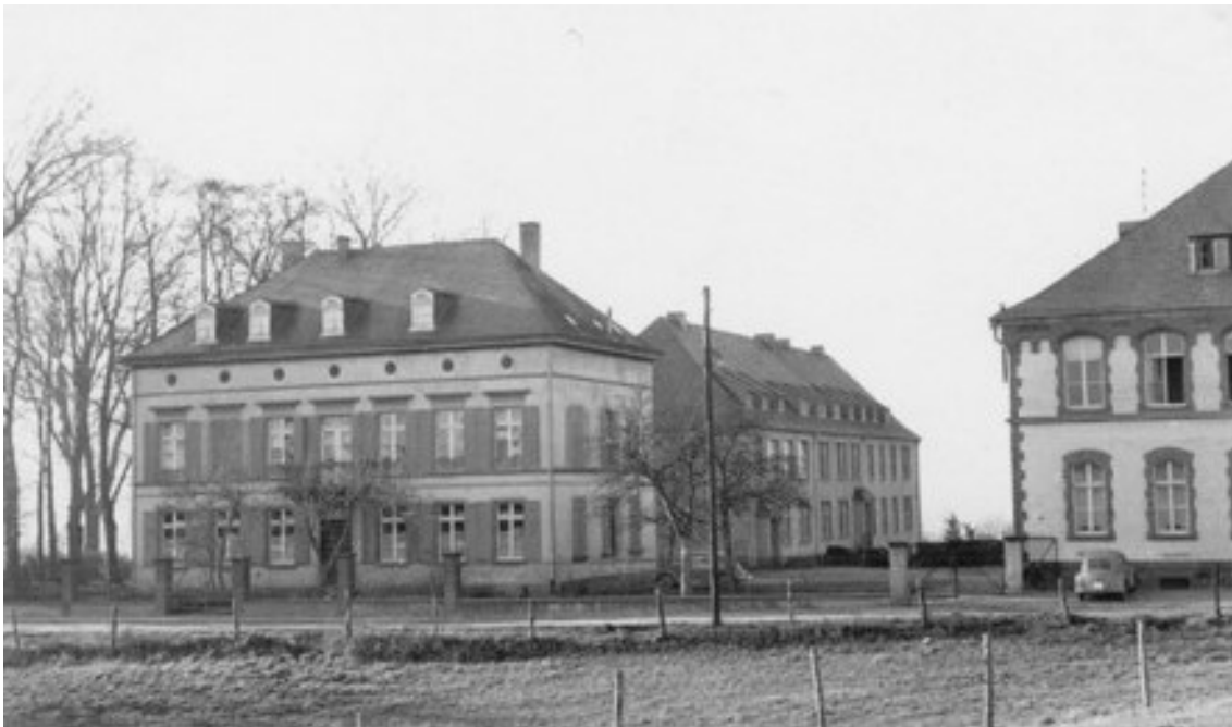
Abb. 4: Schul- und Internatsgebäude sowie Weckbecker-Schlösschen (Zustand bis 1983)
