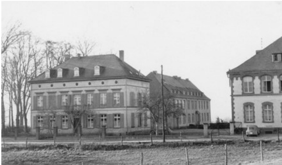
Abb. 4: Schul- und Internatsgebäude sowie Weckbecker-Schlösschen (Zustand bis 1983)
